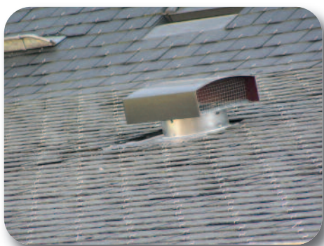
Sortie toiture STS - Sur le toit.
