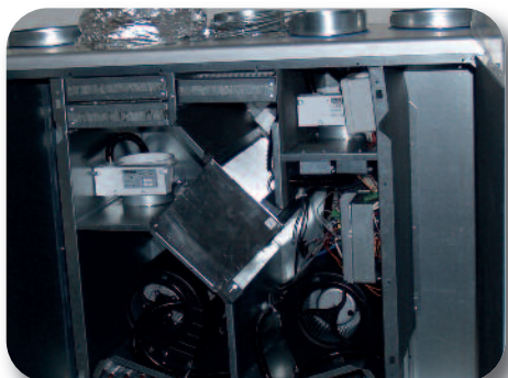
Centrale - Local technique.
