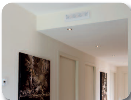
Faux-plafond permettant l'installation du caisson de répartition.
