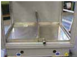
Bac à condensats avec raccordement à l'évacuation
