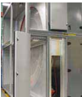
Trappes d'accès / section d'inspection
