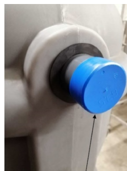
Joint + tube + bouchon Ø63 pour passage de câbles
