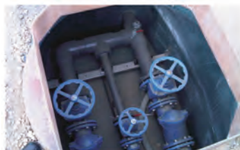
Regard avec robinetterie revêtue époxy et pré moule de dalle de propreté
