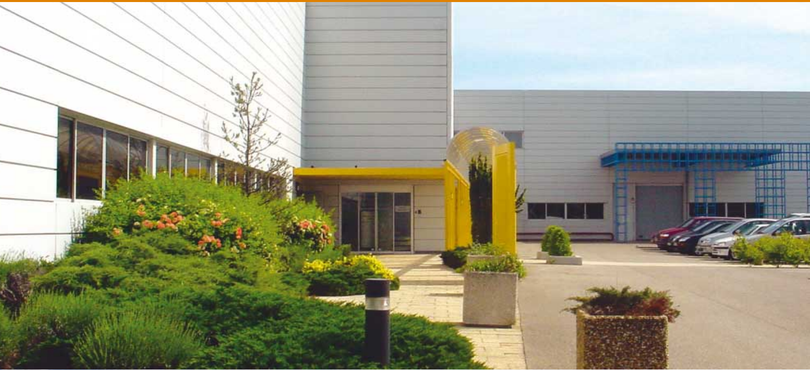
Le Siège de Pompes Grundfos Distribution à St Quentin-Fallavier
