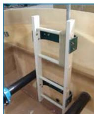
Échelle avec crosse rétractable dans la chambre à vannes. La sécurité, même en dehors de la station.
