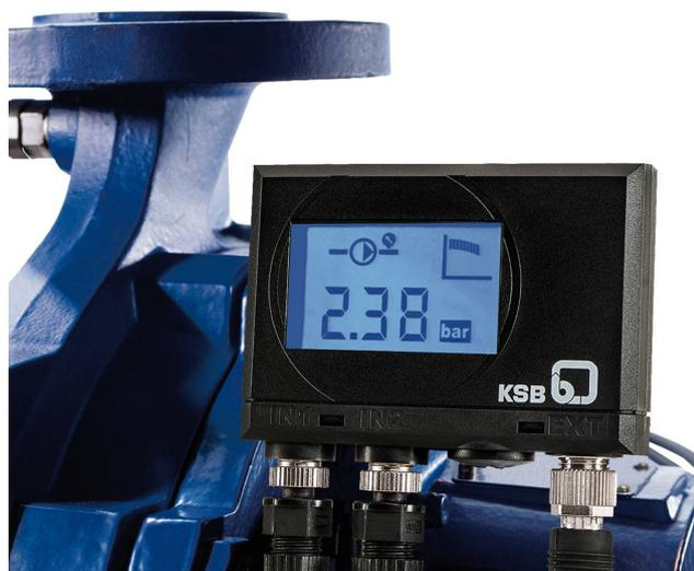
Il enregistre le profil de charge de la pompe pour signaler les potentiels d'optimisation éventuels en termes d'efficacité énergétique et de disponibilité. Il est équipé de deux capteurs de pression et d'un module d'affichage.
