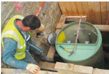
Mise en place d'une station SRP
