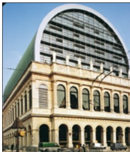
Crédit photo : C. DEMON FAUCON - Architecte : J. NOUVEL
