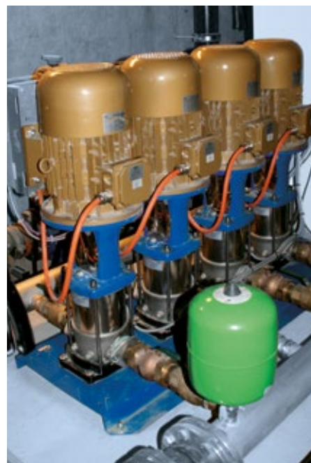
Movitec PumpDrive avec le moteur SuPremE®-IE4*- de KSB
