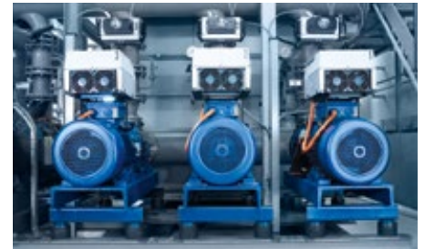
Les pompes Etanorm sont toutes équipées de PumpDrive
