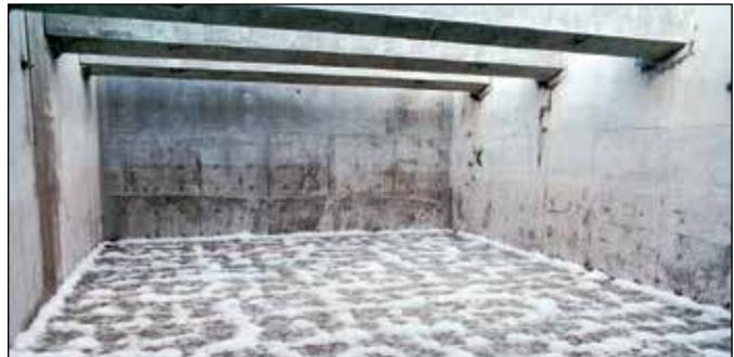
Meilleure action de détassage à l'air – et meilleur nettoyage du média filtrant – conséquence des orifices anti colmatage rapprochés et de la distribution uniforme de l'air sur toute la longueur de l'élément.
