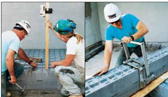
L'installation est facilitée par le fond de filtre à technologie Type S, car les blocs peuvent être mis à niveau à  $\pm 6$  mm (à gauche). L'assemblage des canaux latéraux est simplifié parce que les blocs s'emboîtent simplement les uns dans les autres pour former des canaux latéraux de distribution efficaces et étanches (à droite).
