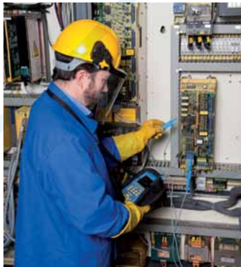
Sur la partie contrôle commande électronique d'une machine-outil, vérification du bon fonctionnement.
