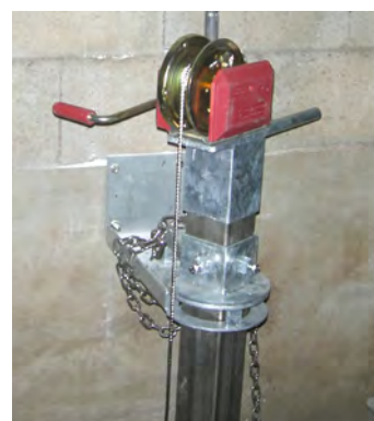
Fixation contre le mur de fosse
