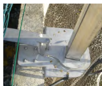
Fixation sur le mur de fosse
