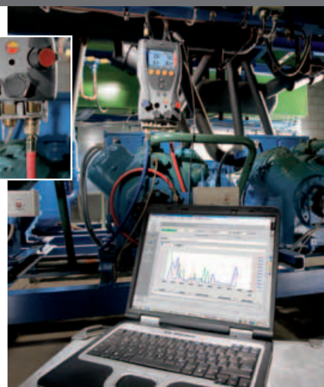
Mise en service, maintenance d'une installation frigorifique avec testo 556 et 560
