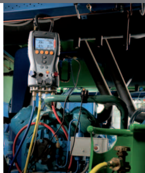
Le remplissage d'une installation via un testo 556/560
