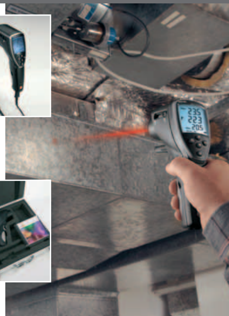
Contrôle de la température dans des gaines de ventilation
