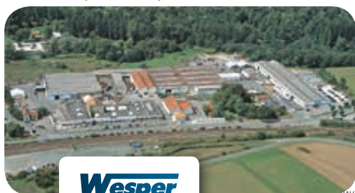
Site de production à Pons (France)
