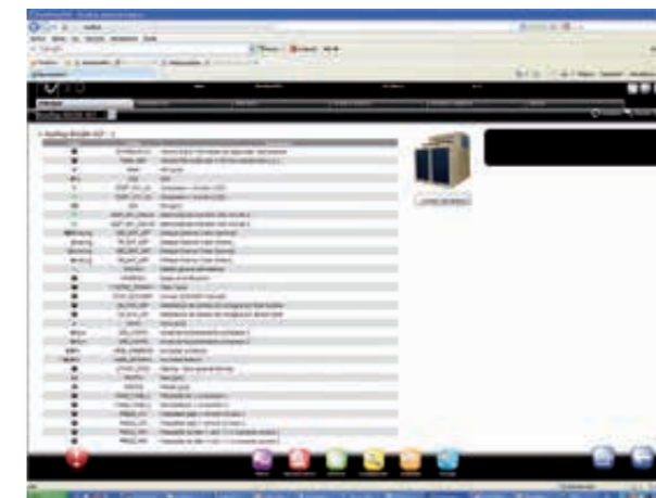
Écran détail Roof Top : permet de visualiser toutes les variables et de modifier tous les paramètres à travers le PI@nt Visor.
