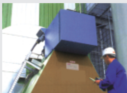
Mesures sur site
