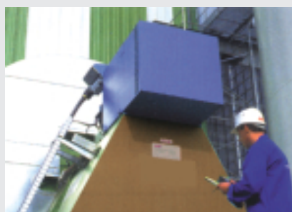
Mesures sur site
