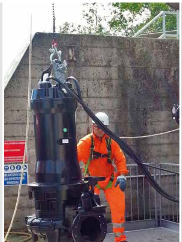
Station de pompage eaux d'égout chargées (Italie) 4 pompes ZUG CP 250B 45/6 AW
