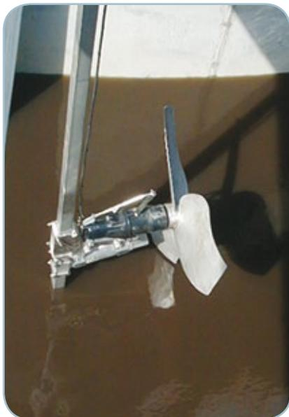
Le mélangeur de base est fourni avec glissière de guidage et crochet de levage, toute la charpenterie peut être fournie en fer galvanisé à chaud ou en acier INOX.
